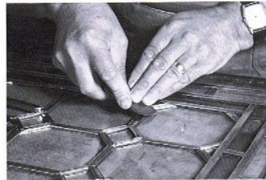
684 Montage des châssis vitrés dont le masticage. XVIII e siècle.
